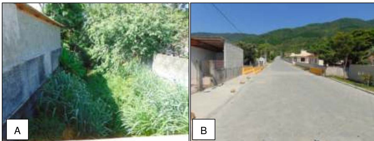
Figura 28 – A) Visualização do ponto crítico. B) Tubulação a montante
