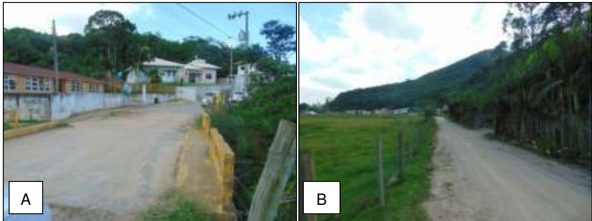
Figura 12 – A) Ponte sobre a via. B) Ponto de inundação.
