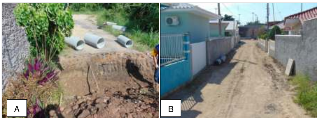
Figura 44 – A) Visualização geral da via. B) Ponto da via em obras.
