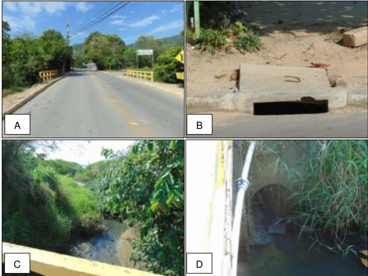
Figura 29 – A) Visualização da travessia. B) Boca de lobo simples. C) Córrego a jusante. D) Tubulação que recebe as águas pluviais da via.
