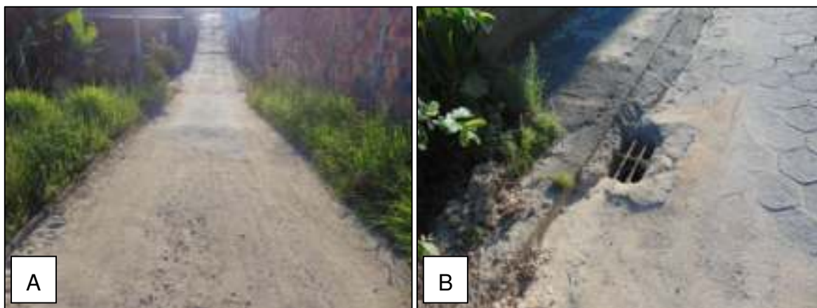
Figura 8 – A) Visualização geral da via. B) Dispositivo de captação de águas pluviais.
