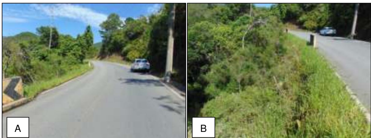
Figura 36 – Localização do ponto crítico na rodovia.
