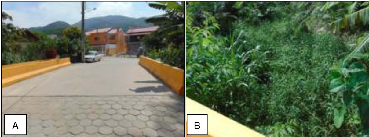
Figura 23 – A) Visualização da ponte. B) Córrego assoreado a montante.
