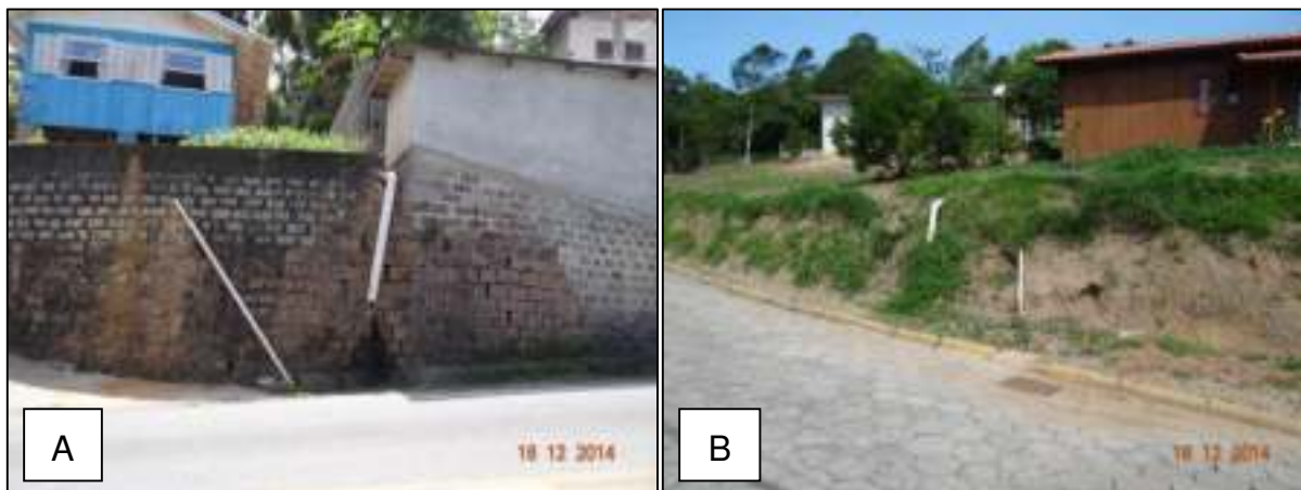
Figura 42 – Despejo de esgoto sanitário doméstico na sarjeta da via
