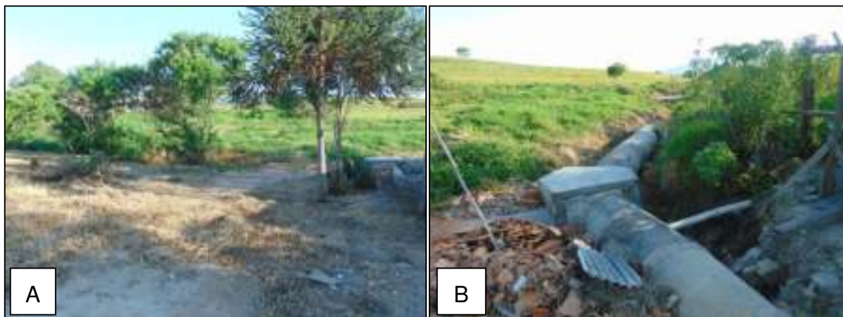
Figura 9 – A) Final de rua. B) Tubulação com ligação do esgoto sanitário.
